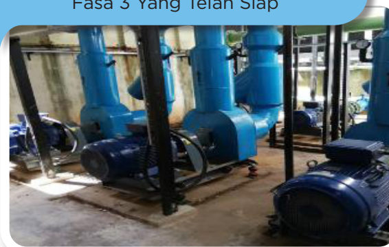
Gambar Penggantian Sistem Chiller Fasa 3 Yang Telah Siap
