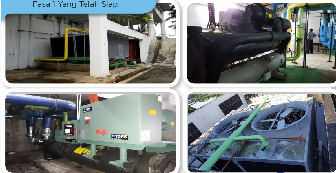
Gambar Penggantian sistem chiller Fasa 1 Yang Telah Siap
