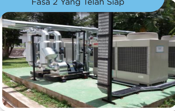
Gambar Penggantian Sistem Chiller Fasa 2 Yang Telah Siap
